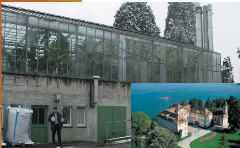
Gewächshaus mit Heizzentrale
