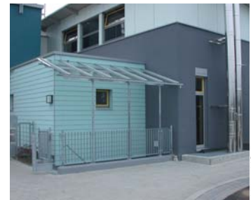
Die Heizzentrale - außen
